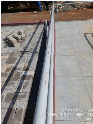
f) Muro: muro com revestimento quebrado e não consertado;
