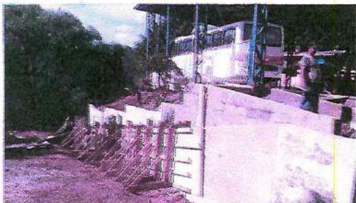
MADEIRA E PREGOS UTILIZADOS NA CAIXARIA PARA REFORMAS DO MURO DE PROTEÇÃO
