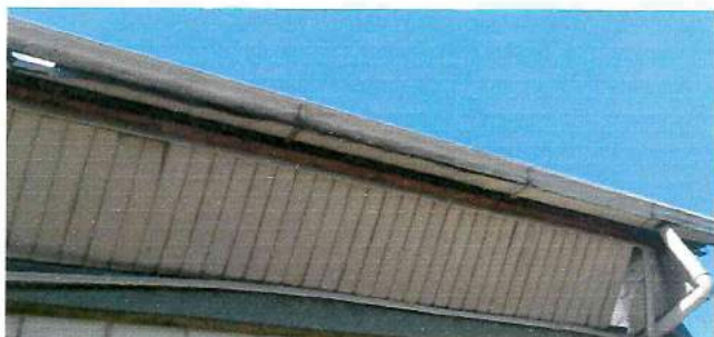
SUBSTITUIÇÃO DAS CALHAS
